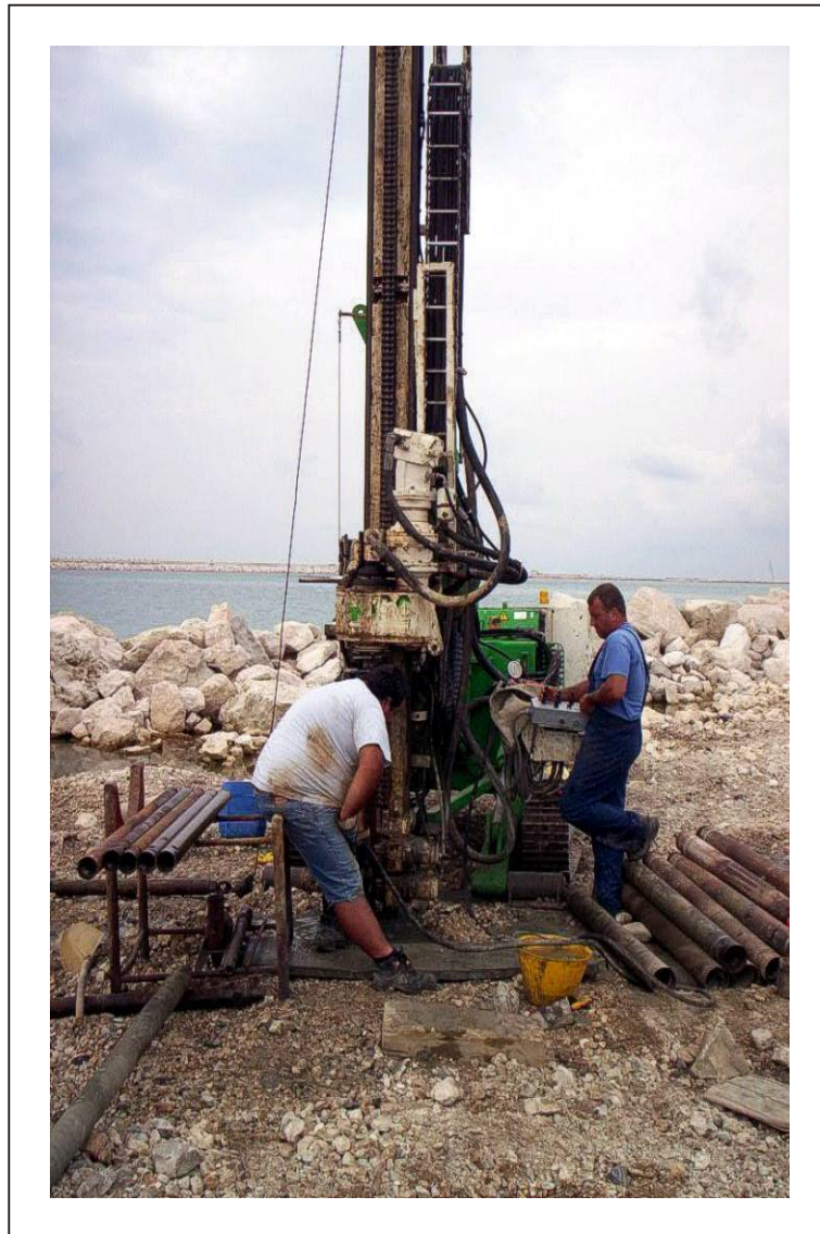
Postazione Sondaggio 2006-S2 Cantiere: Banchina Rettilinea - Porto di Ancona
